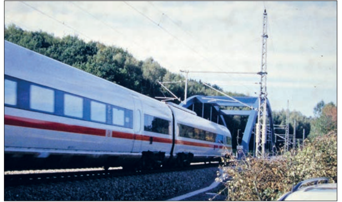
Der ICE passiert die im Jahr 2000 neugebaute Struthbrücke.
