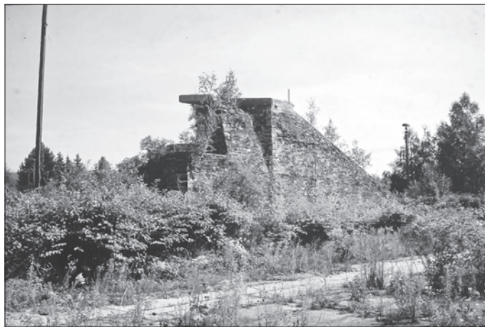
Nie fertiggestellte Brückenpfeiler für die Annaberger Strecke.
